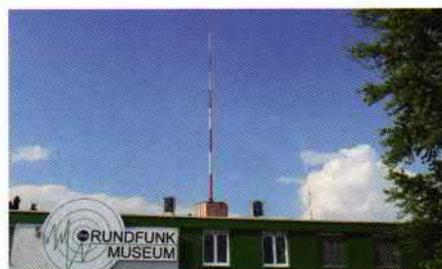
Bild 15: Sendemast und Abstimmhaus auf dem Dach des Gebäudes
