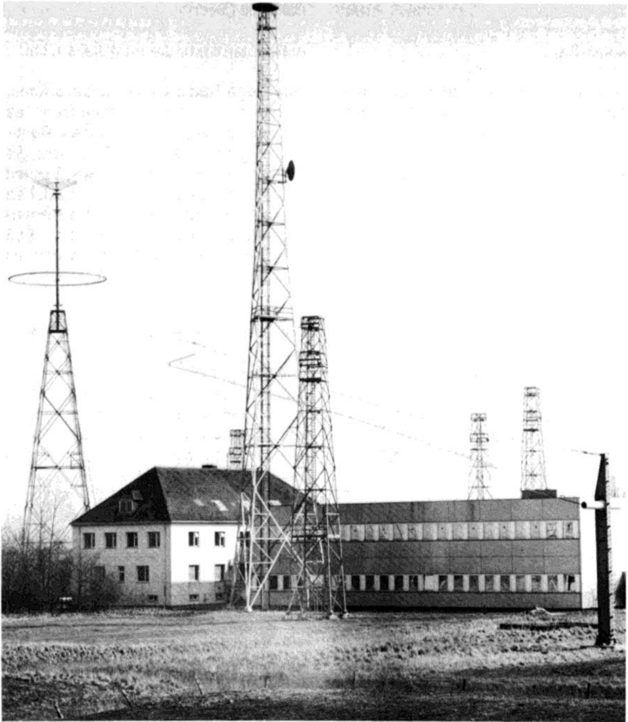
Bild 3: Betriebszentrale und Empfangsfunkstelle Utlandshörn
