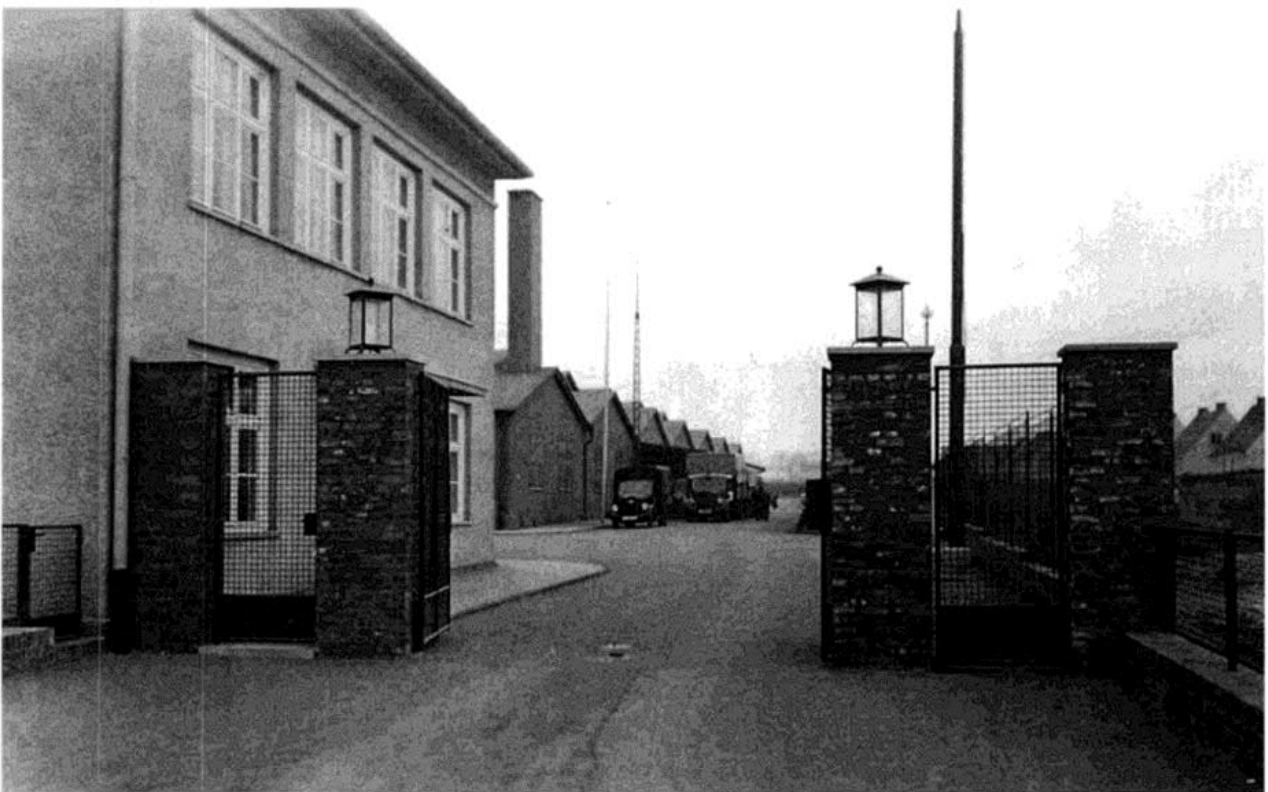
Bild 4: Der alte Haupteingang, 1938
