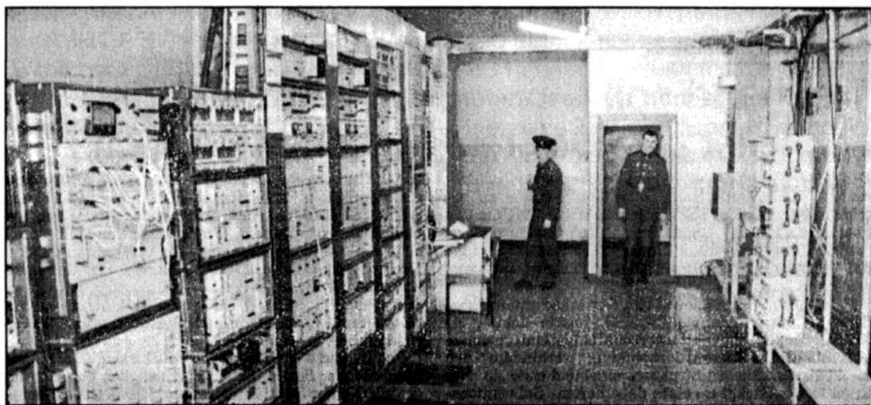
Bild 9: Nachrichtenzentrale der GUS-Streitkräfte im Tiefbunker
