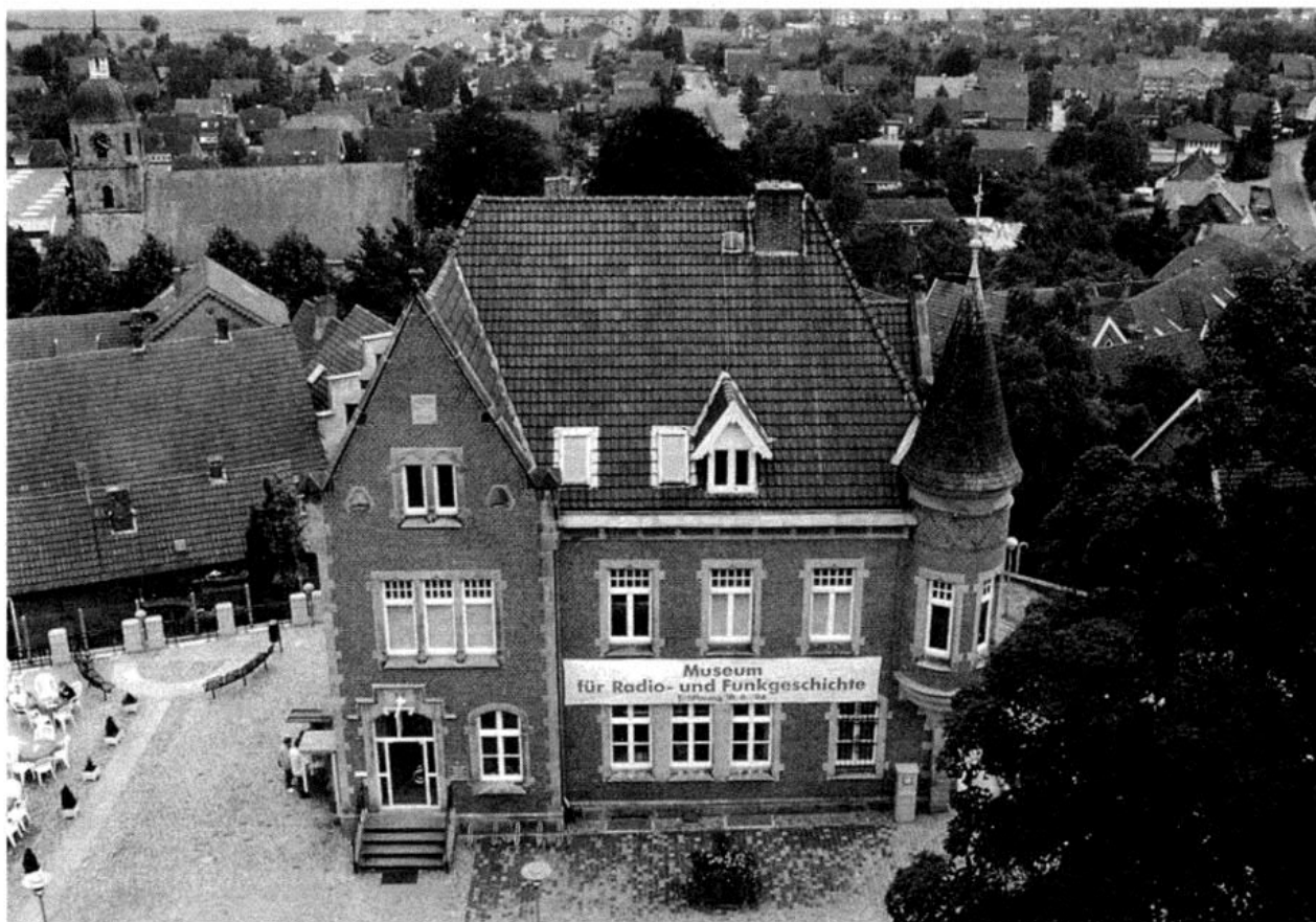
Bild 1: Blick von der Burg auf das neue Museum für Radio- und Funkgeschichte in Bad Bentheim
